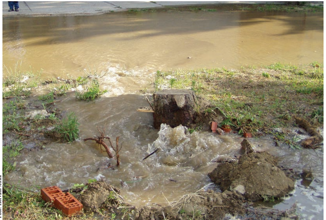
Szinte a fa gyökerei közt fut a nyomóvezeték. A fa előbb volt ott...
