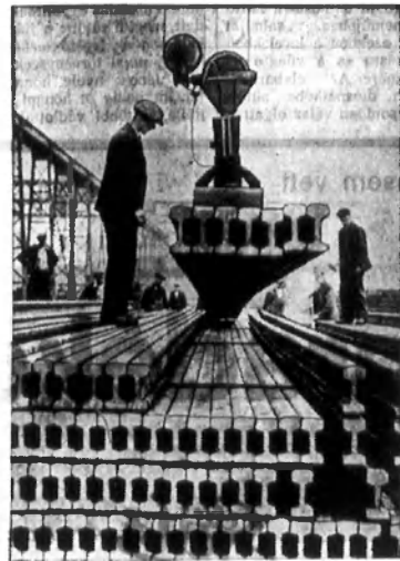
Elektromos daru 5000 kilogramm vasúti sílra emel egyzserre a workingtoni acélgégyárban
